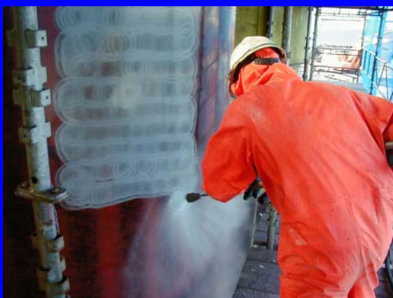
Fjerning av rust og maling
