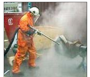
Fjerningen av rust og maling skjer ved at små mengder med abrasiver blandes i vannet under høyt trykk og spyles ut med et trykk på cirka 750 bar.
