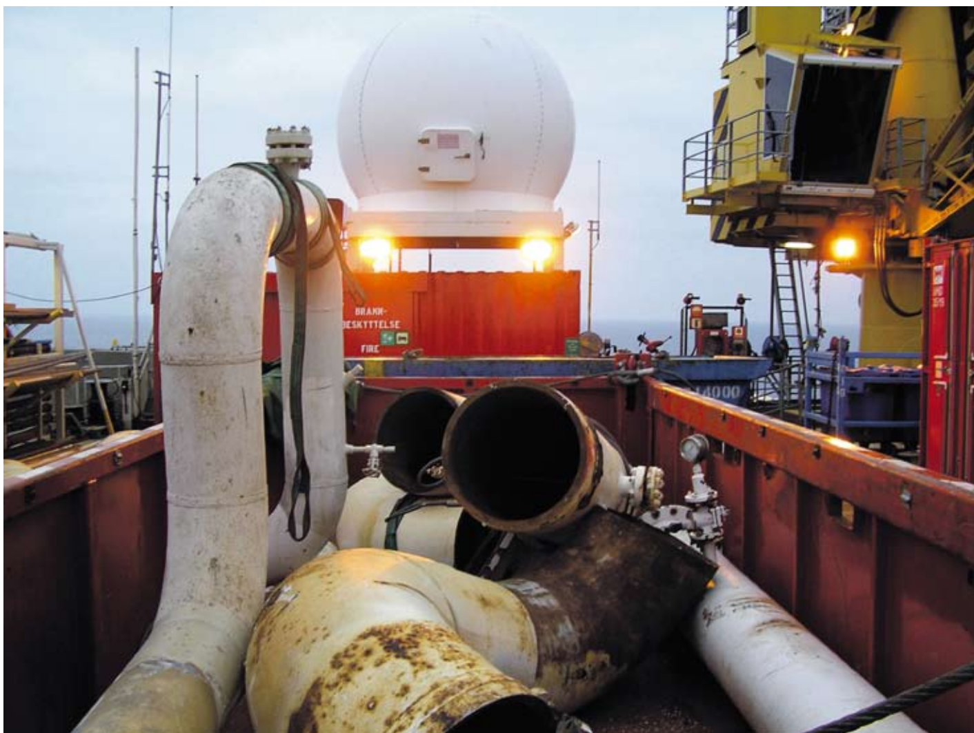
50 TONN: Watech gjorde en jobb på ConocoPhillips på plattform B11 som besto i å kutte en 24 tommer tykk rørledning. I løpet av et par uker ble over 50 tonn stål fjernet – bare med vann og sand.
